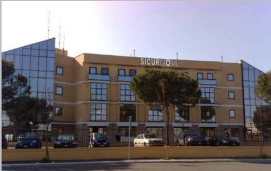
Nuova sede di Roma: la struttura di Viale De Chirico.
